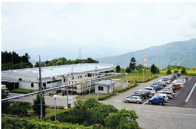
(上) 赤城工場 管理棟 (右下) 屋内試験場
