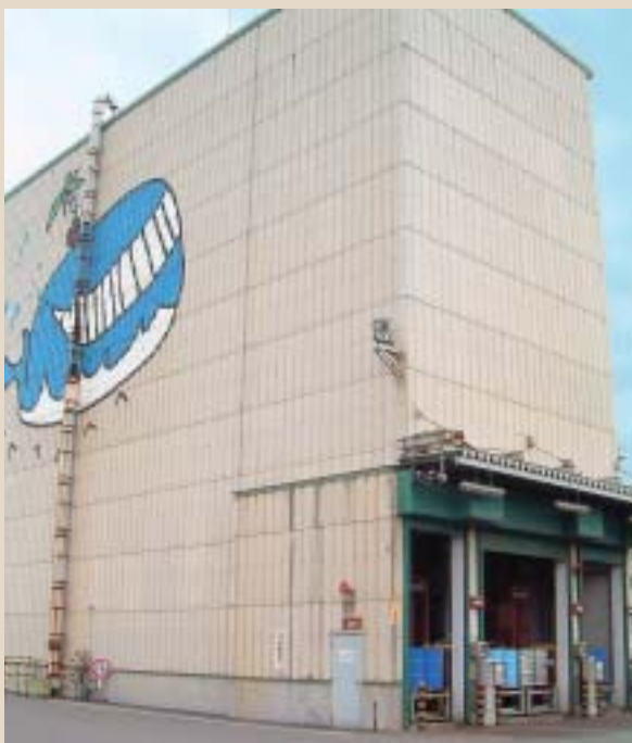
危険物立体自動倉庫(左)
