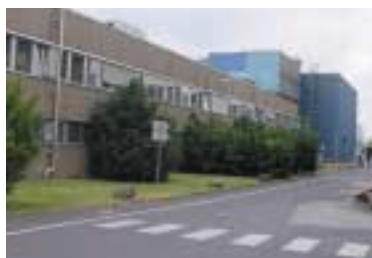
工場外観(奥のブルーが新工場スペース)
